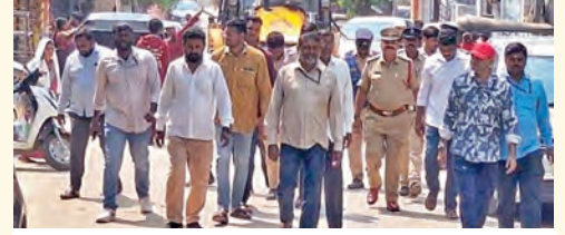
అడగర్లలో వెలిసిన అక్రమ నిర్మాణాలను తొలగిస్తున్న జిహెచ్ఎస్ అధికారులు
